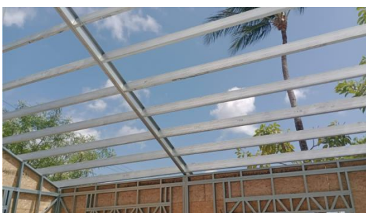
Figura 3 - Estrutura do telhado
