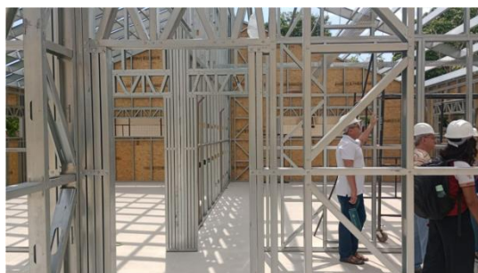
Figura 2 - Estrutura em aço galvanizado revestida com placas OSB
