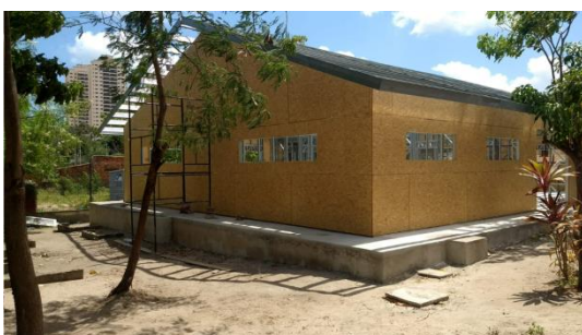
Figura 4 - Obra em steel frame
