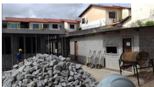
Figura 8 - Área de vivência da obra
