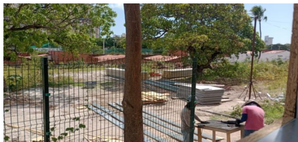
Figura 6 - Área operacional do canteiro de obras
