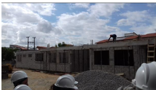
Figura 7 – Obra em alvenaria convencional
