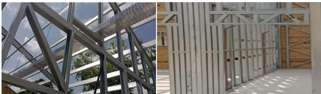
Figura 5 - Instalações elétricas e hidráulicas
